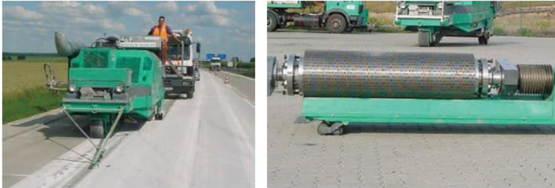
**Bild 18: Grindingmaschine (links: Grindingmaschine, rechts: neue Grindingwelle)**
