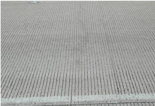
**Abbildung 10: Transverse tining auf Interstate 45 in Houston<sup>5</sup>**
