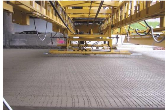
**Abbildung 11: Erstellung von transverse tining in Chicago, Illinois.<sup>6</sup>**
