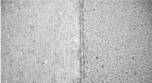
**Bild 44: Grindingtextur (links), Waschbetontextur (rechts)**
