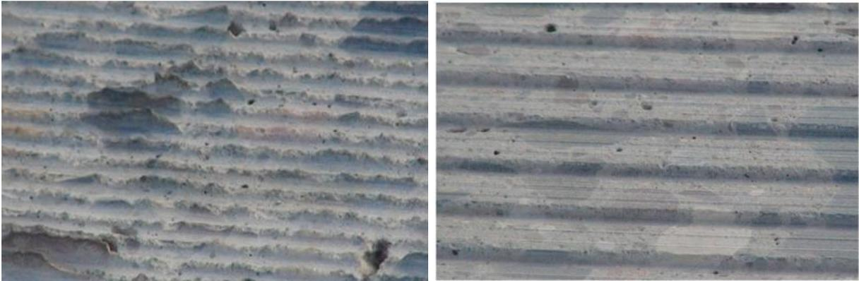
**Abbildung 16: links: Konventionelle Grindingoberfläche, rechts: Next Generation Concrete Surface (NGCS) [Scofield, 2014]**
