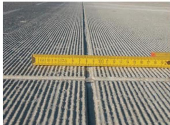
**Bild 17: Textur nach dem Schleifen (Grinding) (links: in der Übersicht, rechts: im Detail)**
